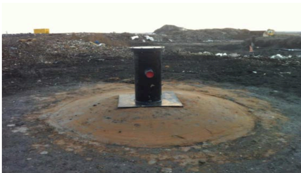
Рисунок А4-2 Multriwell V-типа, помещенный под углом и подключенный к 1 коллектору на полигоне Vink
