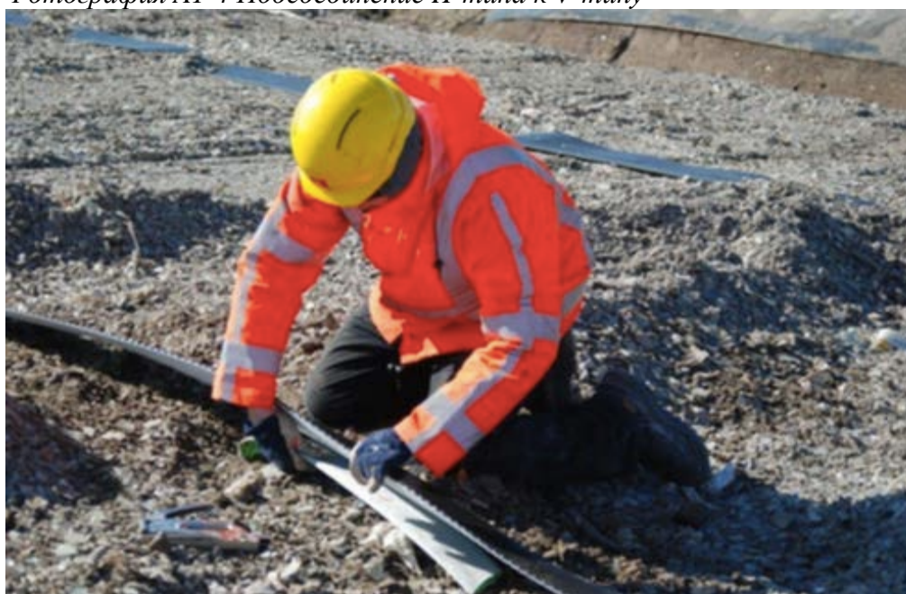
Фотография А1-4 Подсоединение Н-типа к V-типу
