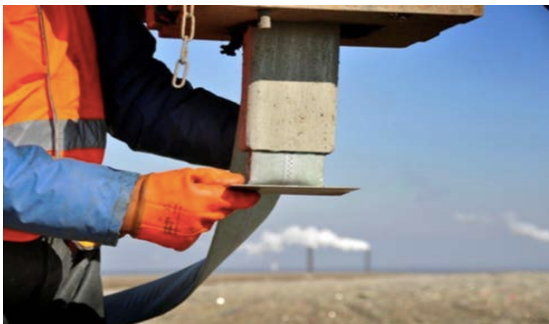
Фотография А1-2 Установка Multriwell V-типа
