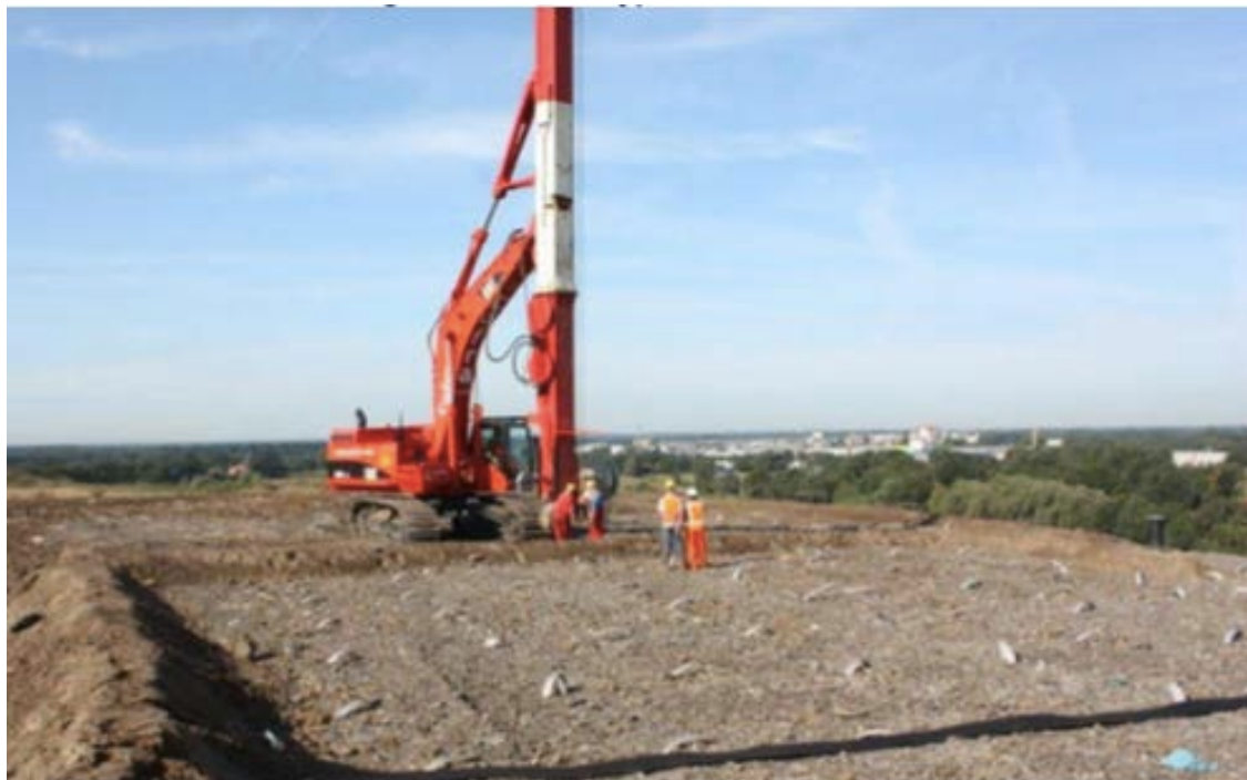
Фотография А1-2 Установка Multriwell V-типа
