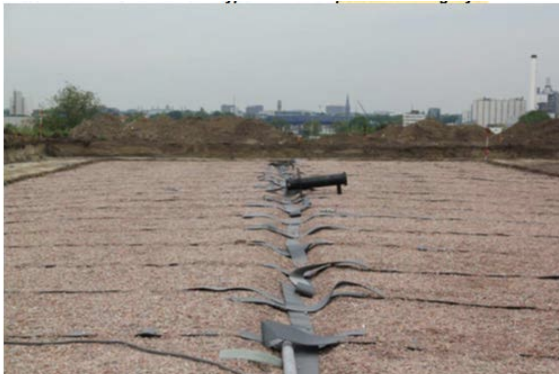
Фотография А1-6 Общий вид Н-типа на пористом выравнивающем покрытии
